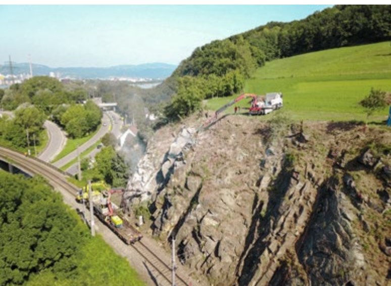
Österreich, Steyregg: Rodungsarbeiten und Böschungssicherung
